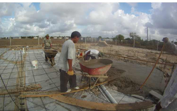
pouring the slab
